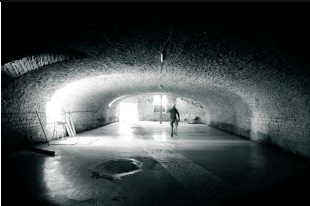
La cave en chantier au début de l'été
